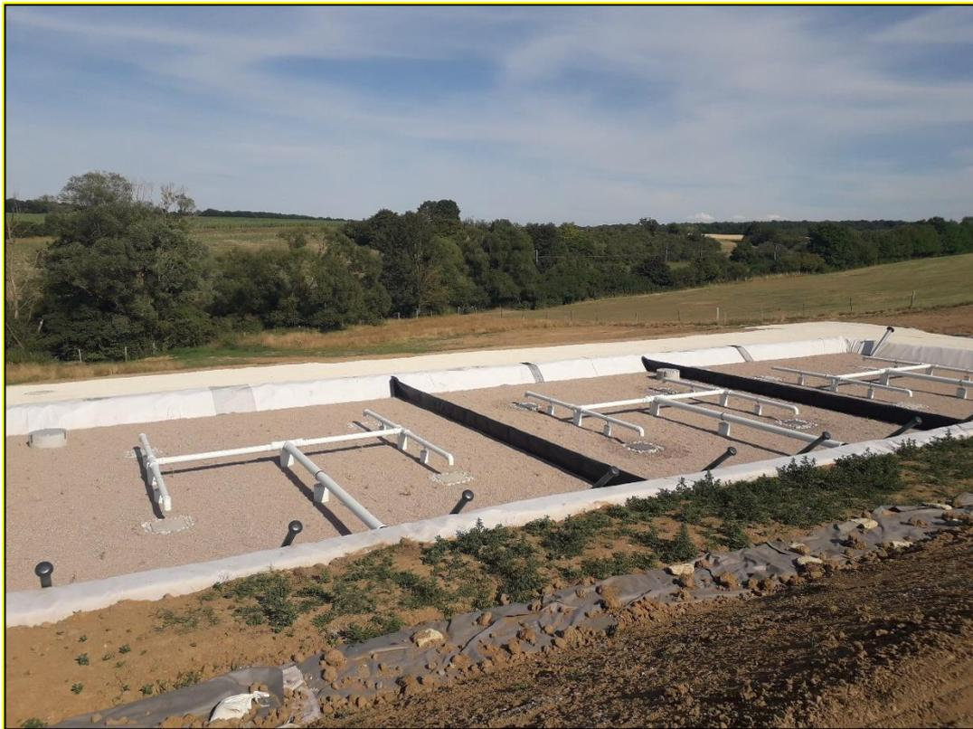
Figure 28 : Filtre planté 1 étage de taille similaire (170EH) à Charmois
